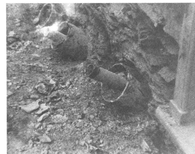
Fig. n. 7 - Le testate dei tiranti: si possono notare i tubi metallici di rinforzo \varnothing 200 mm ed i tubi in plastica della prolunga superiore dei tiranti.
