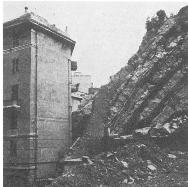
Fig. n. 2 - Andamento tipico della formazione rocciosa nella zona di via Venezia. La giacitura delle bancate di calcari è molto inclinata a franappoggio.
